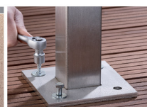
Pfosten ausrichten und montieren.
